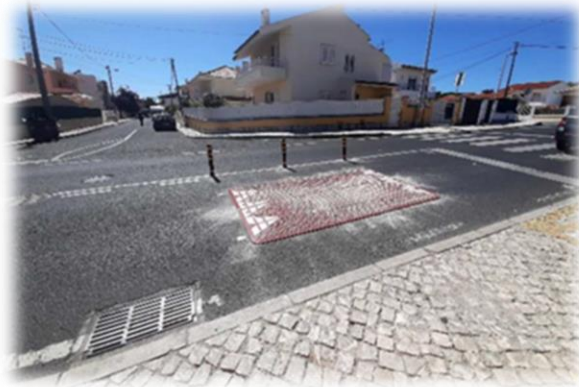
Figura 5 - Instalação de almofadas redutoras em várias localidades do concelho
