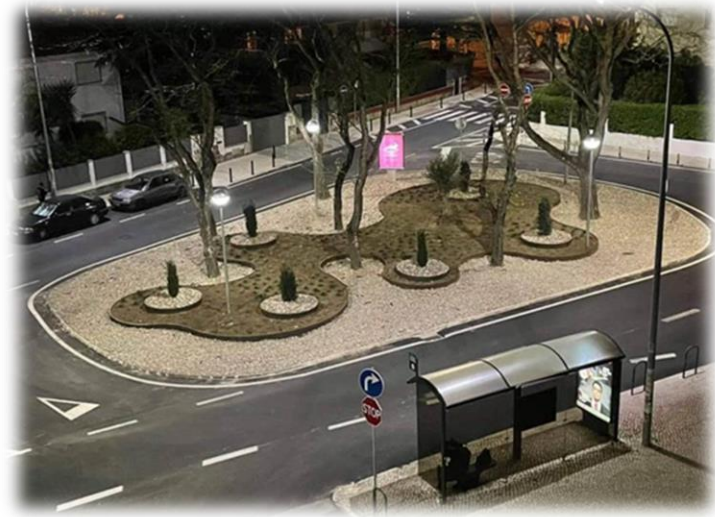
Figura 17 - Substituição de iluminação pública para tecnologia LED
