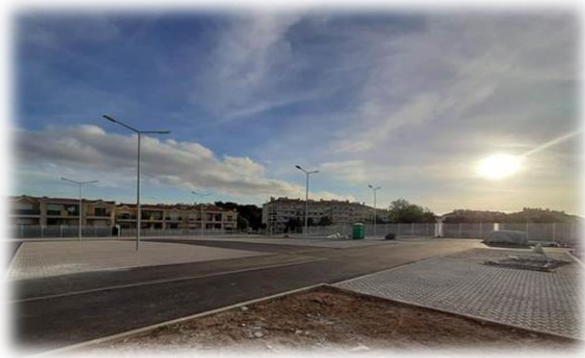
Figura 6 - Estacionamento da Quinta de S. Gonçalo
