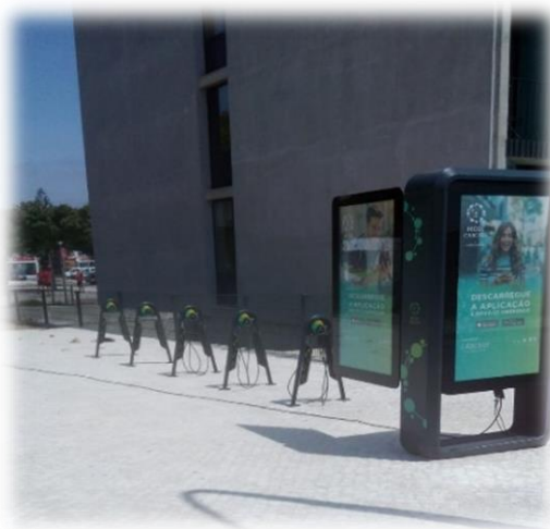
Figura 16 - Nova estação "Lombos Sul"
