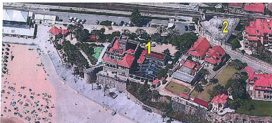
Fig. 49. Chalet Barros e jardim (1) edifício da antiga garagem, cocheira e cavalariça da casa de António Santos Jorge (2) (Classificado como IIP), in, https://geocascais.cascais.pt/# , consultado em 17.05.2019.
