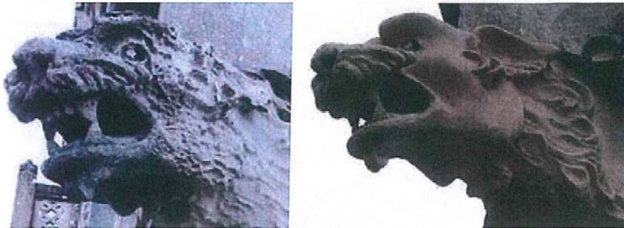
Fig. 20-21. Gárgula, antes e depois da intervenção de conservação e restauro, in http://www.archeofactu.pt/frontoffice/default.aspx?ctrl=experiencia_det&id=131&cid=1
