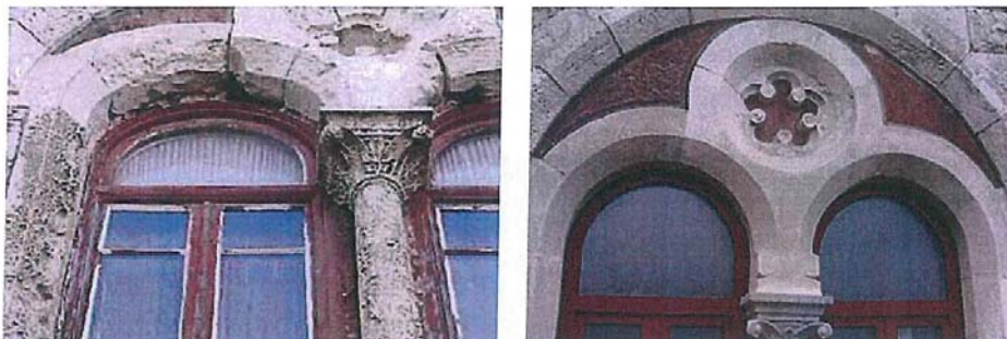
Fig. 10-11. Exemplo de uma janela, antes e depois da intervenção de conservação e restauro, in http://www.archeofactu.pt/frontoffice/default.aspx?ctrl=experiencia_det&id=131&cid=1
