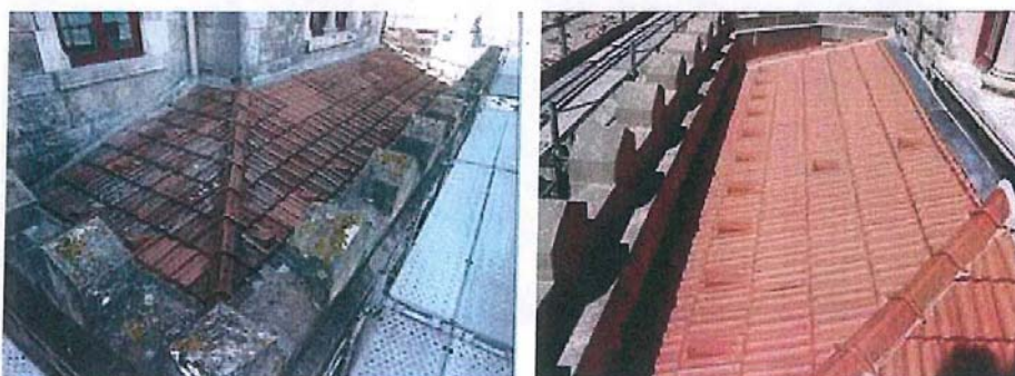
Fig. 12-13. Cobertura, antes e depois da intervenção de conservação e restauro, in http://www.archeofactu.pt/frontoffice/default.aspx?ctrl=experiencia_det&id=131&cid=1
