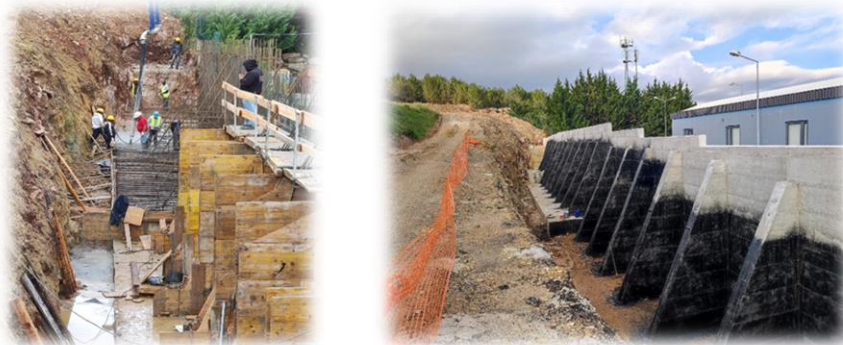
Figura 14 - Muro de contenção no parque da Adroana
