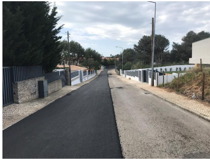
Figura 8 - Repavimentação da Rua das Papoilas, Birre
