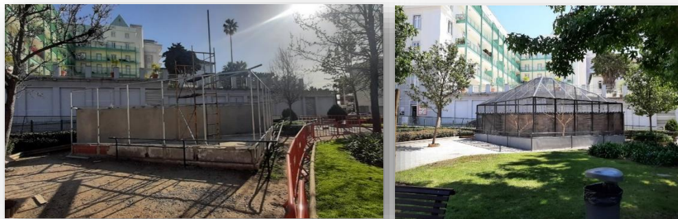
Figura 11 - Requalificação da gaiola do jardim dos passarinhos
