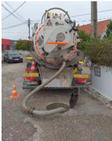
Figura 10 - Limpeza e desobstrução de coletores e
