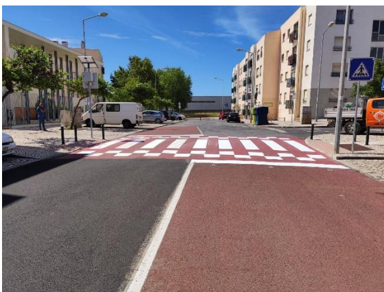
Figura 9 - Execução de passadeira elevada e pintura de via
